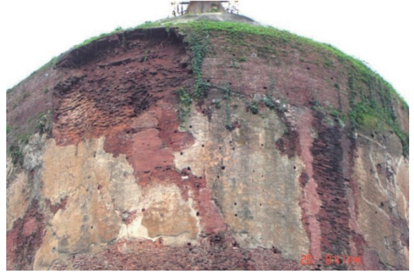
図11 大雨に侵食されたボーボージー (Baw Baw Gyi) 仏塔
