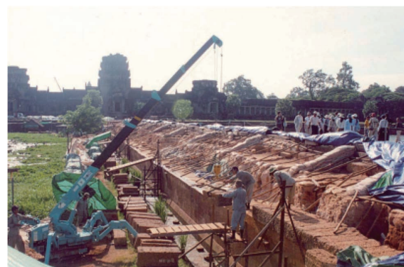
図7 アンコール・ワット西参道工事の様子
