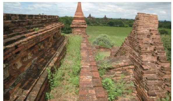
図17 樹木と草の繁茂による破壊（バガン遺跡）
