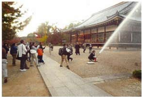
写真8 仁和寺・消火栓システム
