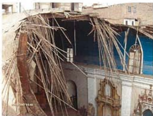
写真4 天井構造
