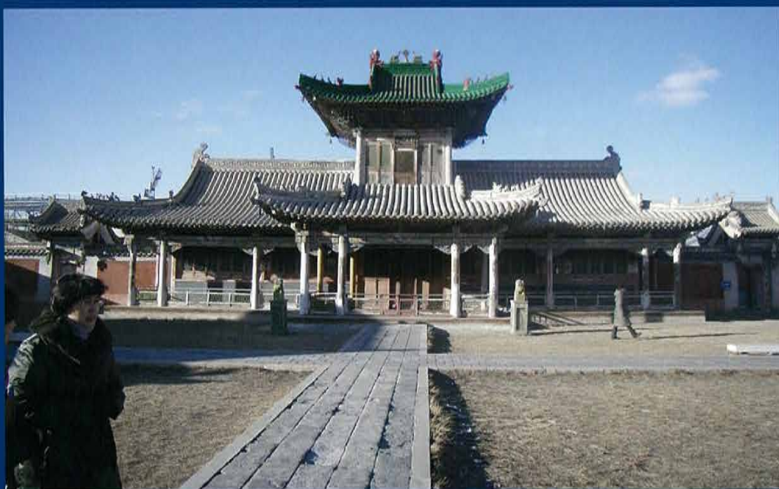
モンゴル国内の文化財建造物修復会社が修復を開始したものの、屋根の一部に施工したところで教育・文化・科学省の命令で中止された。
