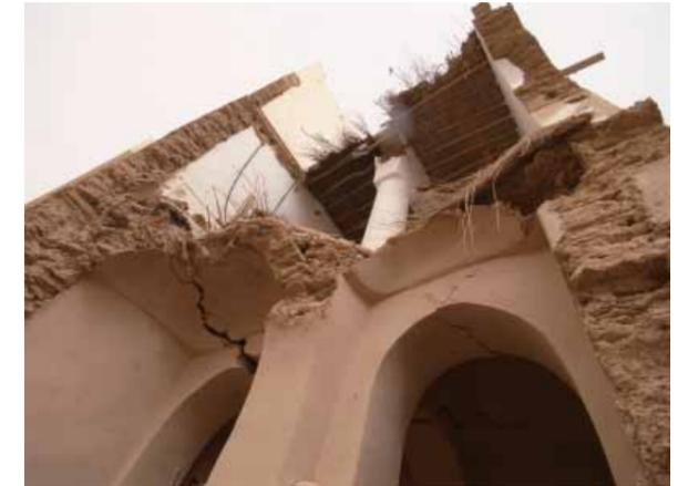
図 15-2 建物内部の露呈部分, 室内のアーチ構法
