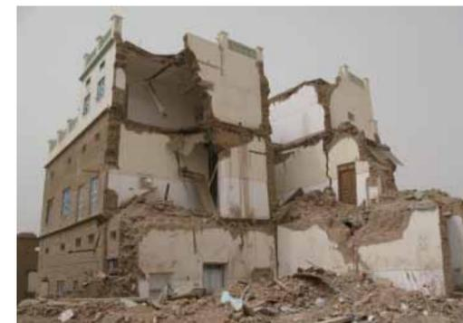
図 7-5 半壊して内部が露呈した住宅
