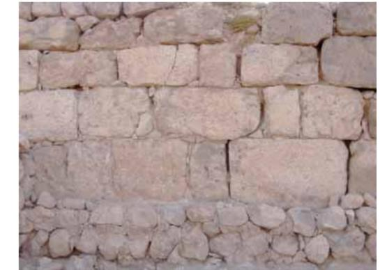
図 1-4 矩形切石による石積み
