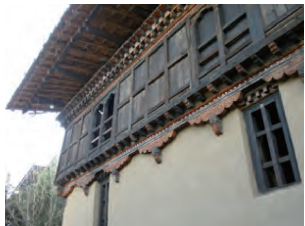
同本館見上げ 写真 3-4-2
