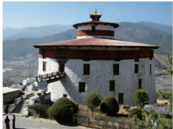
本館外観（北東より） 写真 3-5-2
