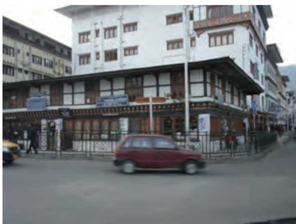
同所角の町家建築 写真 3-1-3
