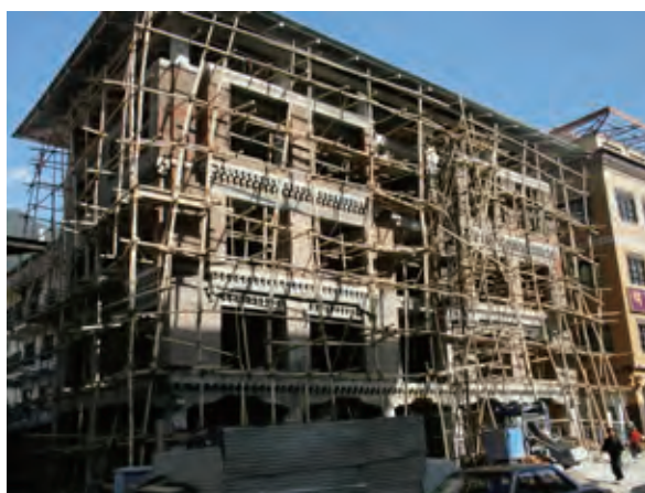
建設中のビル 写真 3-1-4
