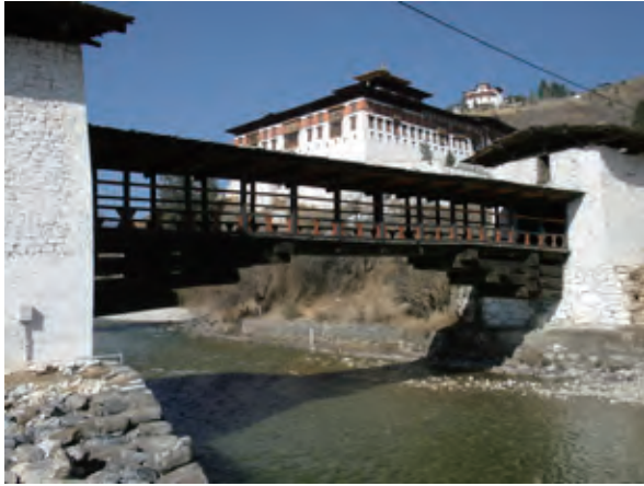
パロ・ゾン入口の屋根付き橋 写真 2-3-1
