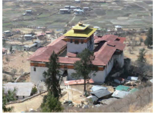
東方よりゾン全景 写真 2-3-2
