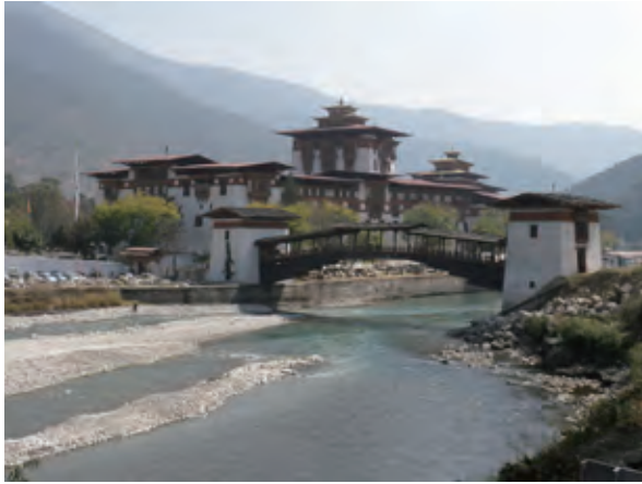
最近復元された屋根付き橋 写真 2-5-1-2
