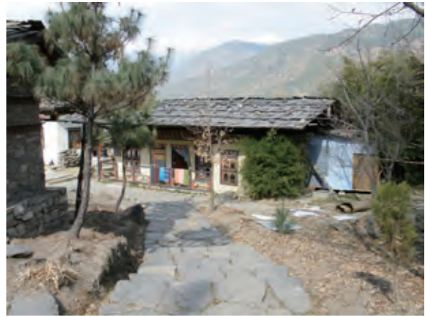
事務棟の外観 写真 3-4-4
