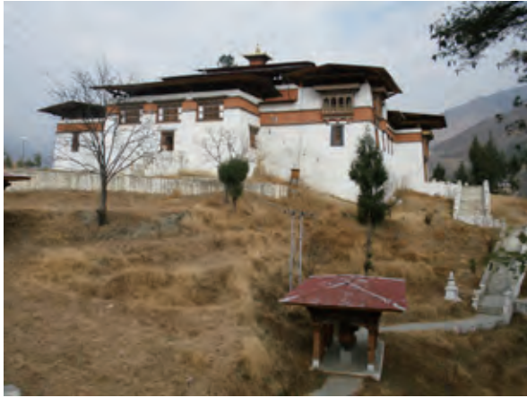
シムトカ・ゾン南面全景 写真 2-2-1
