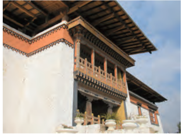
復原された東面入口 写真 2-2-2
