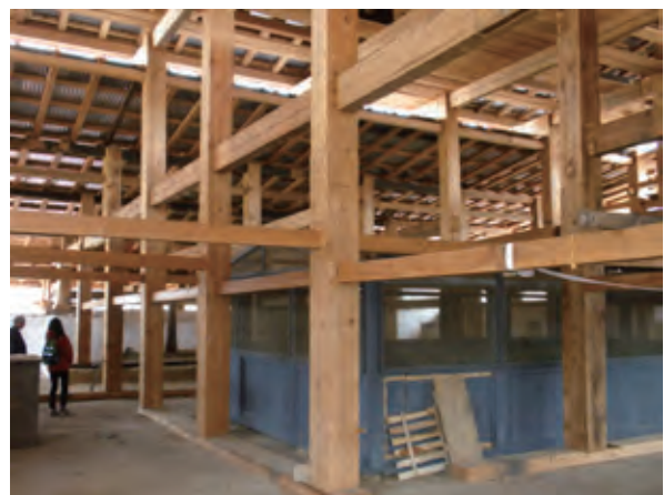
ウツェ屋上の復原屋根小屋裏 写真 2-2-6
