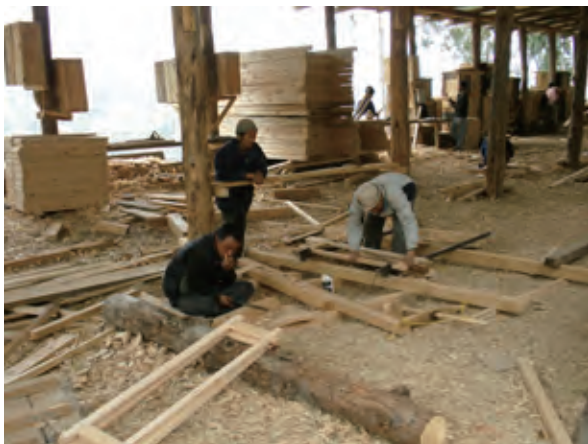
ゾン修理工事の木工作業場 写真 2-4-6
