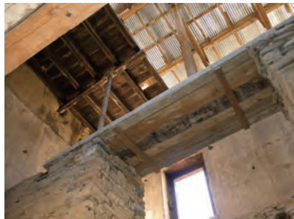
同内部見上げ 写真 2-1-4
