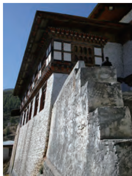
東面外観 写真 1-3-2
