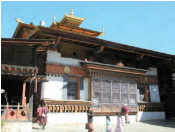
本堂正面外観 写真 1-3-5
