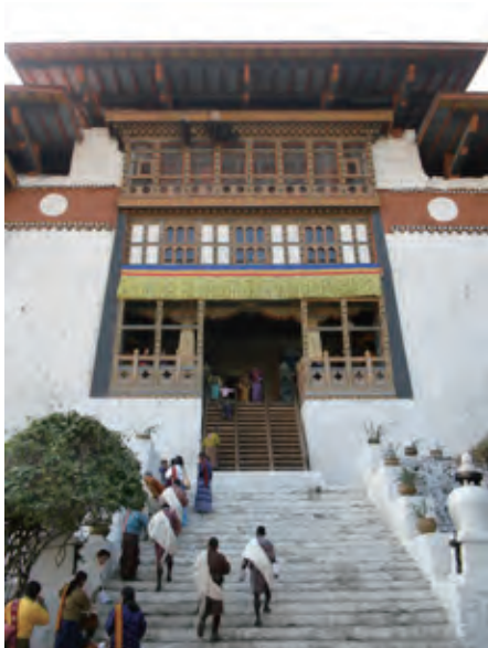
ゾン北面入口部見上げ 写真 2-5-2
