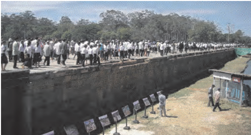
2007 年 11 月に修復工事が完了したアンコール・ワット西参道
