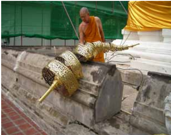
写真 4-2-2：落下した傘状の部分 (Finial) (図 4-6 の 1)
