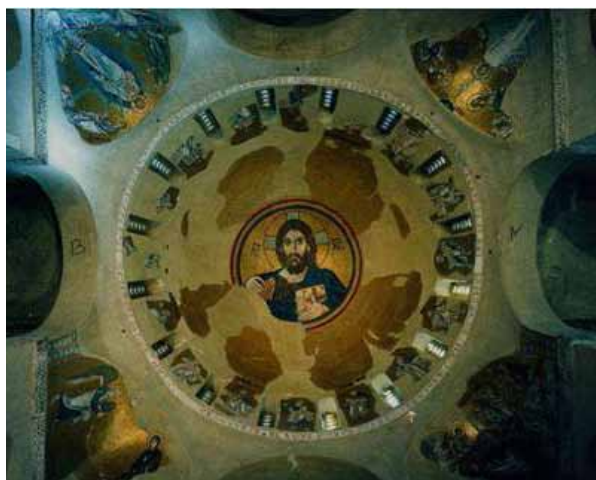
図 4-6 8つのペンデンティブとアーチに支えられた中央のドームとそのドラム (Miltiadou, 2009)
