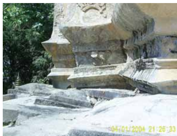
写真 4-1-4 : パゴダ基壇部分。過去の地震や土壌の移動による傾きと修理の繰り返しを示す。
