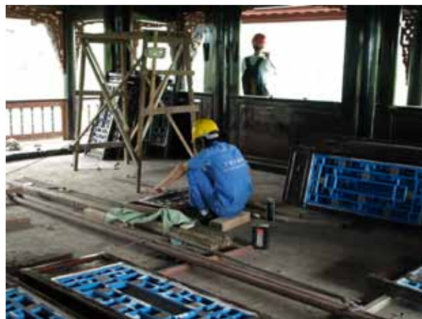
写真 21 伏龍觀の修復施工に当たっている 広西省文物保護センターの職員
