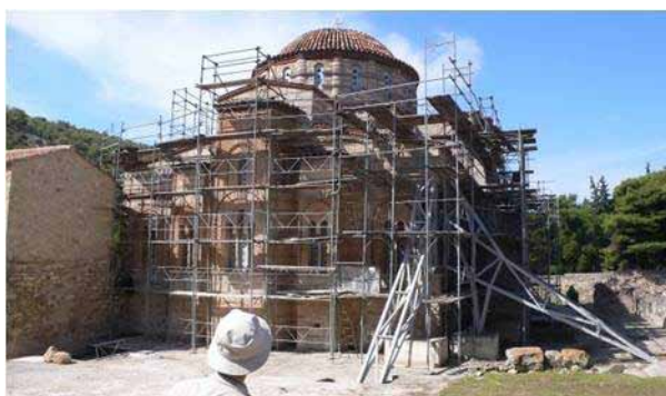
図 2-10 修理中のダフニ修道院
