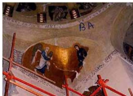
図 4-22 クラックが入ったモザイクはその場で補修された (Miltiadou, 2009)
