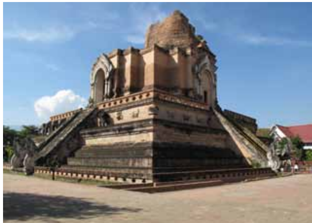
写真 2-4：ワット・チェディ・ルアン（チェンマイ）。上部は地震により大きく崩れているが、1990 年～1992 年に行われた修理の際にも、崩壊して失われた部分は復元しなかった。
