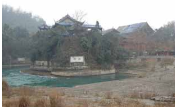
写真9 被災した伏龍観 屋根にビニールシートがかけられている。
