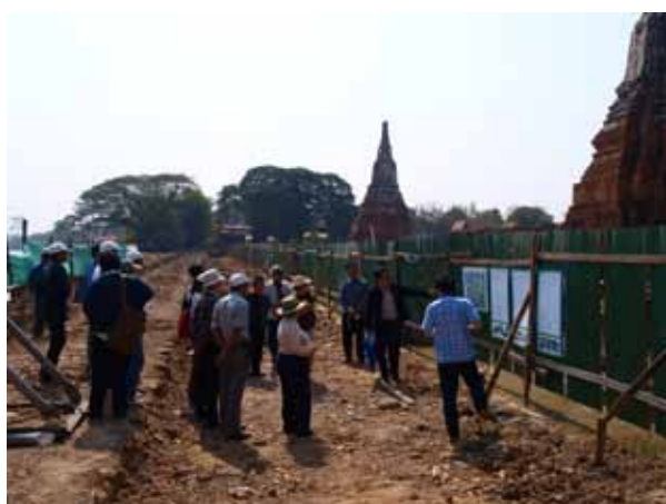
写真 2-3-3: ワット・チャイワタナラム。浸水防止のための工事を行っている。
