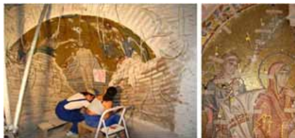
図 4-23 現場におけるモザイクの修復保存作業の一例
