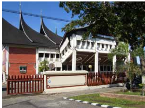
写真22 倒壊する大型施設（2009年11月撮影）
