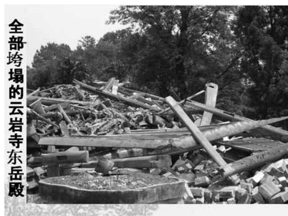
写真3 被災した雲岩寺の様子 (東京文化財研究所編 2009 より引用)
