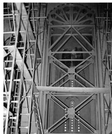
図 4-13 内部の鉛直鋼製支柱 (Miltiadou, 2009)
