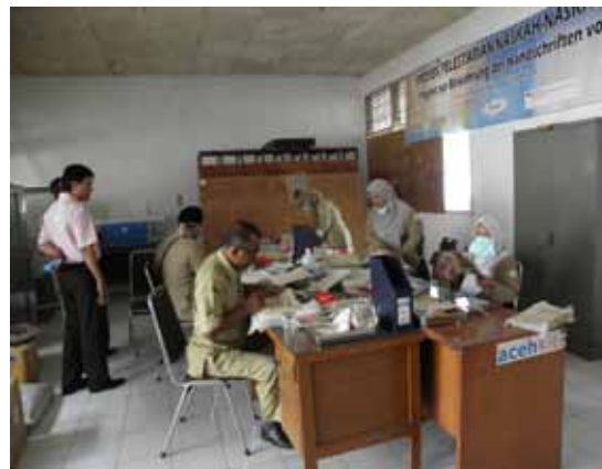
写真 9 修復作業風景
