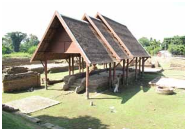
写真 2-2-1 : Ku Pa Dom, ウィアン・クム・カーム遺跡（チェンマイ）。屋根は漆喰の遺構床面を保護するための覆屋。
