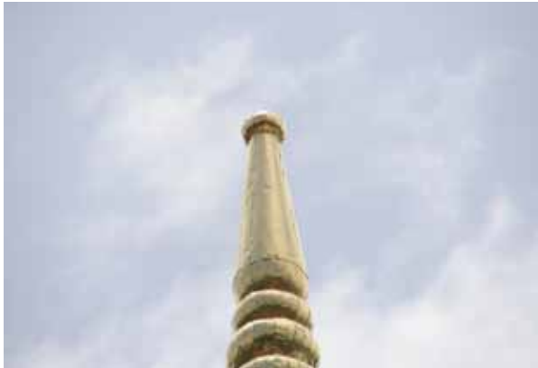
写真 4-2-1：地震の際にパゴダ上部の傘状の部品が落下したことを示す (図 4-6 の 1)
