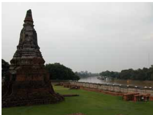
写真 2-3-2: ワット・チャイワタナラム。右側の川と寺院のある場所との標高差が少ないことがわかる。また、洪水対策として、ラテライトの防水壁を構築している。
