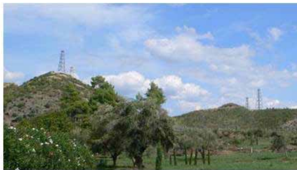
図 4-49 放水砲のタワー
