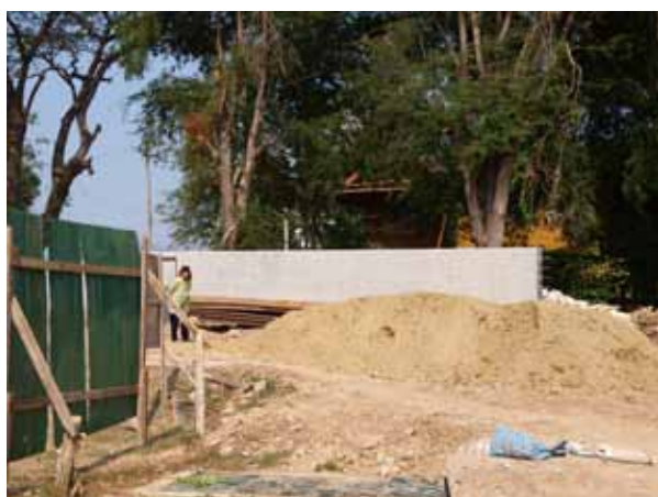
写真 2-3-4: ワット・チャイワタナラム。コンクリート製の防水壁。
