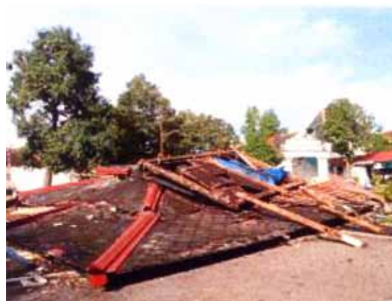
写真 19 ジョグジャカルタ市内王宮関係木造建造物被害 (2006 年 6 月 Jogya Heritage Society)
