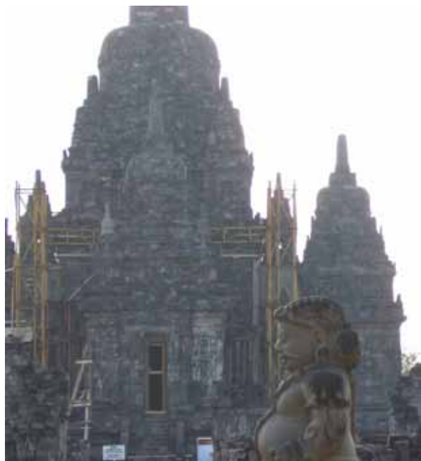
写真 20 中央祠堂に組まれた足場
