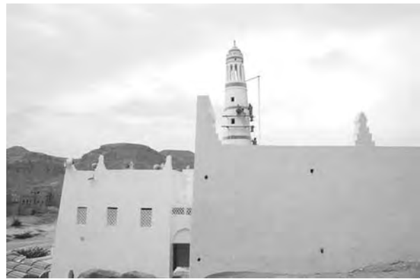
写真3 修復作業終了間近のAynat Al Faqih Mosque（2010年7月）（Prince Claus Fund, Final Report on the Restoration of the Mosque in Aynat, Wadi-Hadramut: Yemen, 16.09.2010より）
