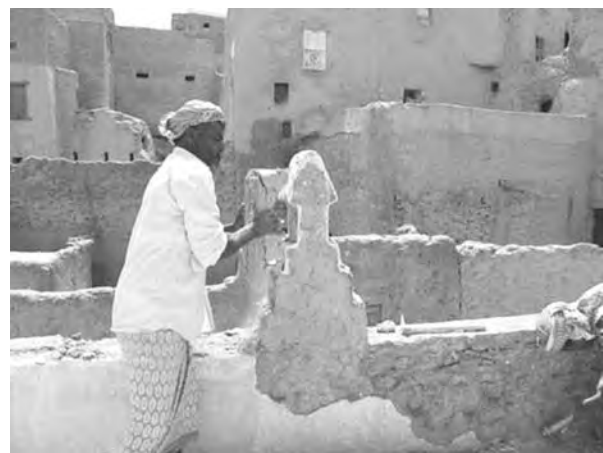
写真4 屋上テラスの欄干の修復作業風景（Prince Claus Fund, Final Report on the Restoration of the Mosque in Aynat, Wadi-Hadramut : Yemen, 16.09.2010より）
