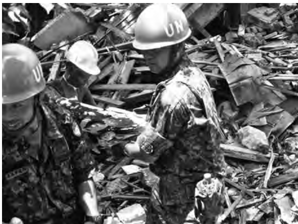
写真9 日本陸上自衛隊による瓦礫除去作業風景 29
