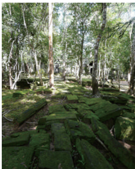
▲石材表面に繁茂する植物
