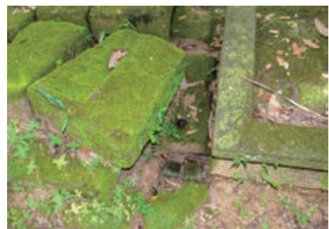
▲現地に設置した砂岩テストピース
