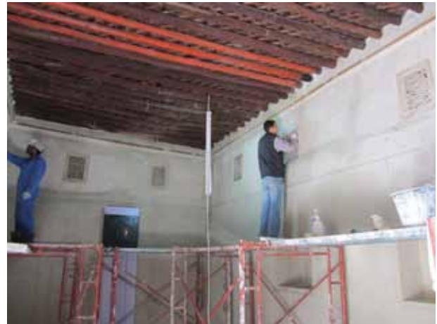
図 88. シャイフ・サルマーン・ハウス室内装飾修復風景
