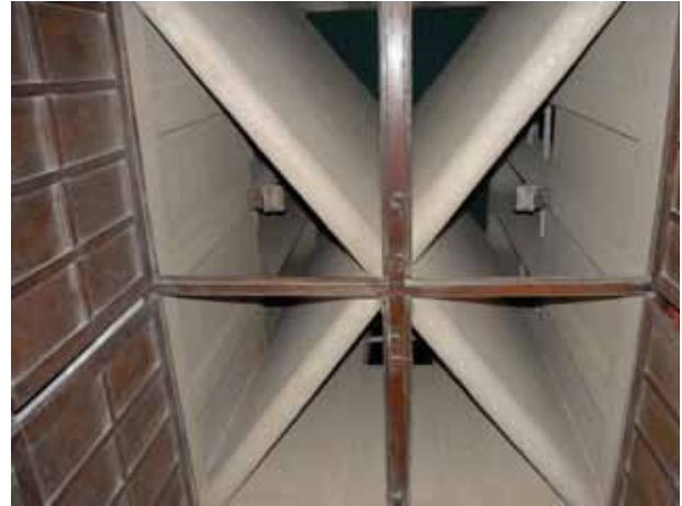
図 92. シャイフ・イーサ・ビン・アリー・ハウスのウィンドタワーの内部構造
