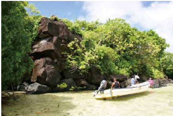
写真 27 外洋周壁周辺の樹木の繁茂
