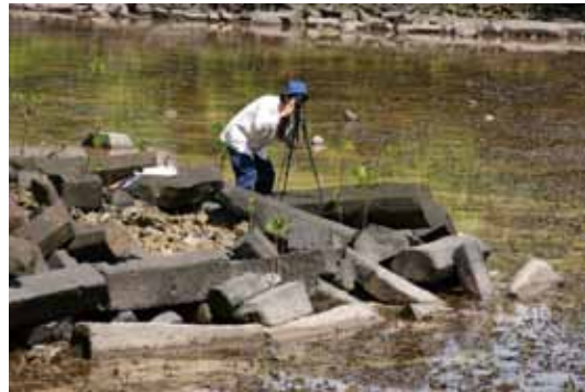
写真7 タウ遺跡の石垣北東コーナーの崩落
