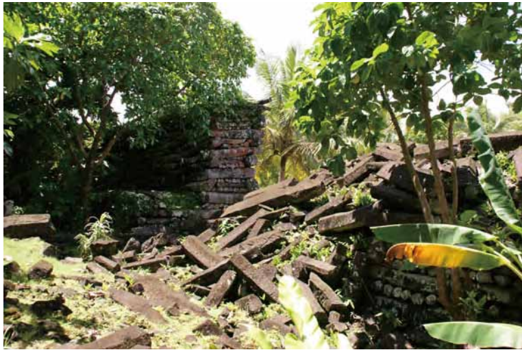
写真 17 内側から見た北側周壁の崩落
