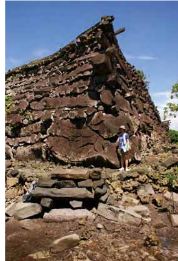
写真 18 外周壁南東コーナーの巨大玄武岩の亀裂
