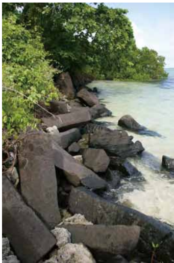
写真 29 石垣の崩落と砂の堆積
