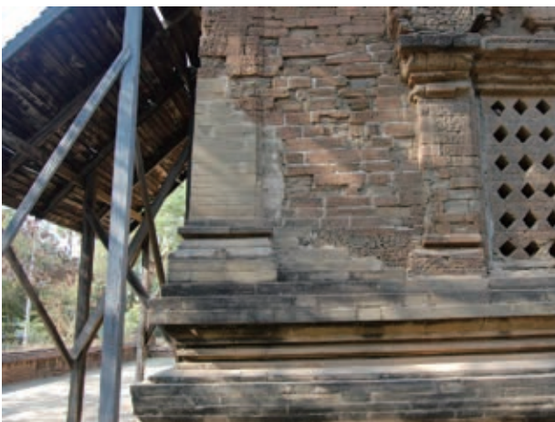
図 27. ナンパヤーの修復された壁隅部と仮設屋根
