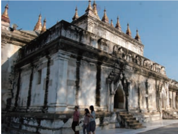
図 29. マヌーハ外観と壁隅の補強材挿入跡
