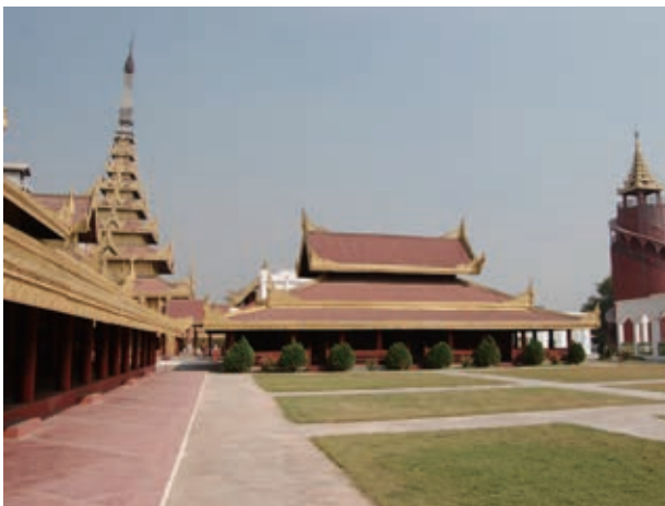
図 54. 復元された宮殿建物群
