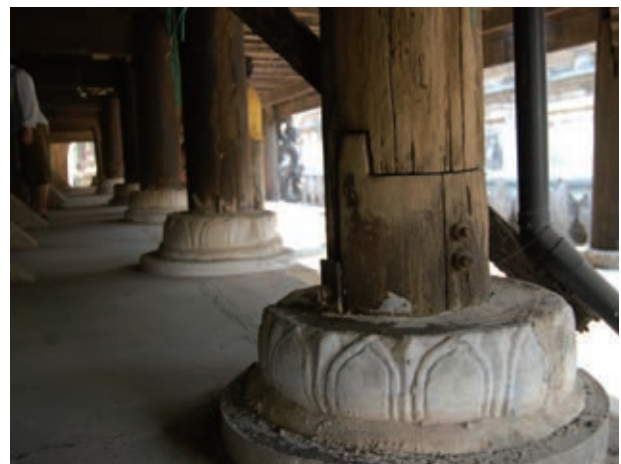
図 61. シュエナンドー僧院礎石の新設と根継補修を施された柱脚部分
