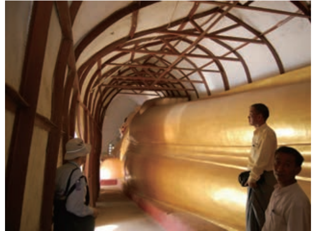
図 30. マヌーハの寝釈迦像と鉄骨支保工
