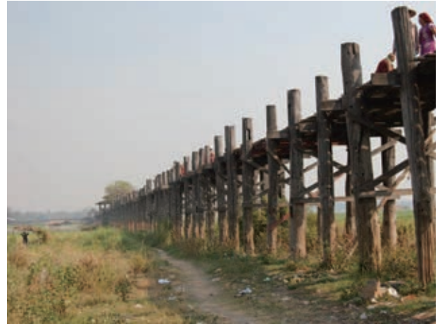
図 92. ウッペイン橋の橋脚部見上げ
