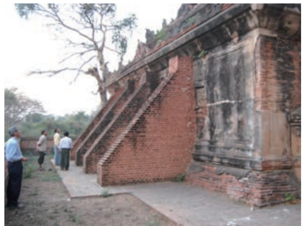
図 40. ピタカッタイ南面外壁の補強バットレス
