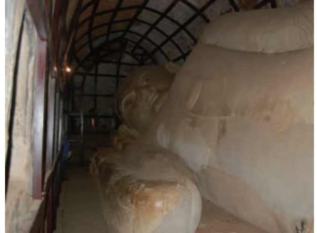
図 38. シンピントリャウン堂内の寝釈迦像と鉄骨支保工
