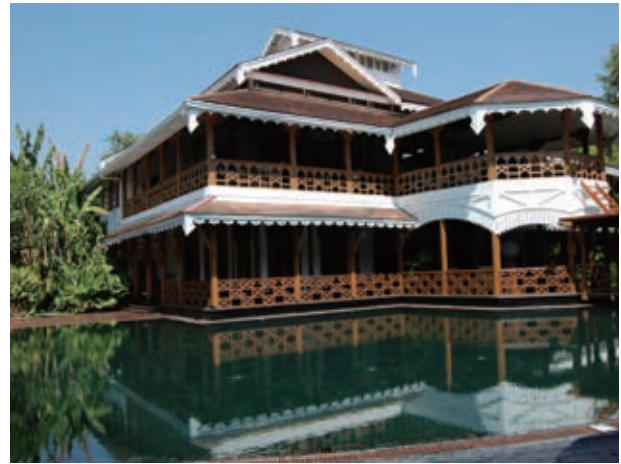
図 110. ホテルに転用された邸宅建築
