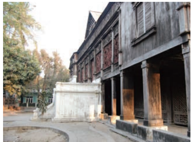
図 65. タハウイン僧院北面外観
