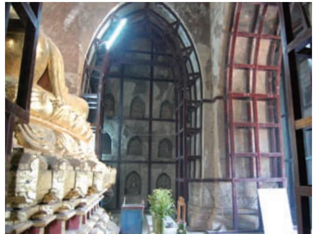
図 15. チャウクーウーミン堂内の鉄骨支保工
