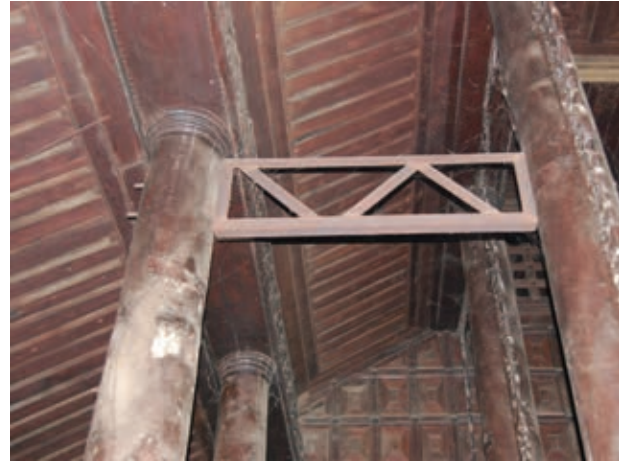
図 69. シュエインビン僧院補強鉄骨トラス
