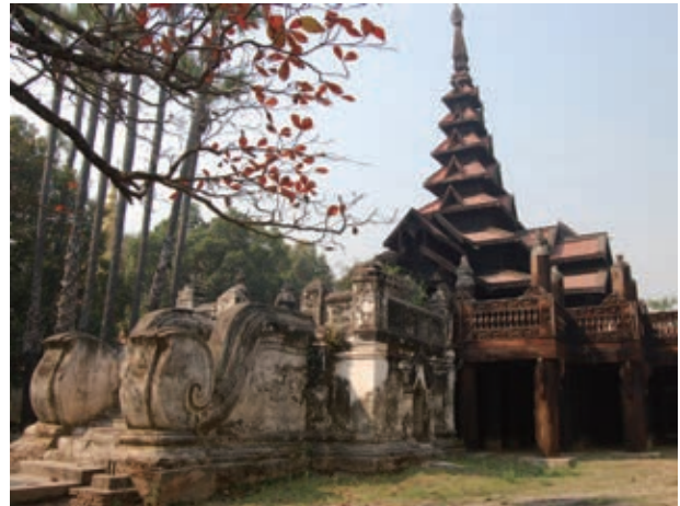
図 77. バガヤ僧院東面外観
