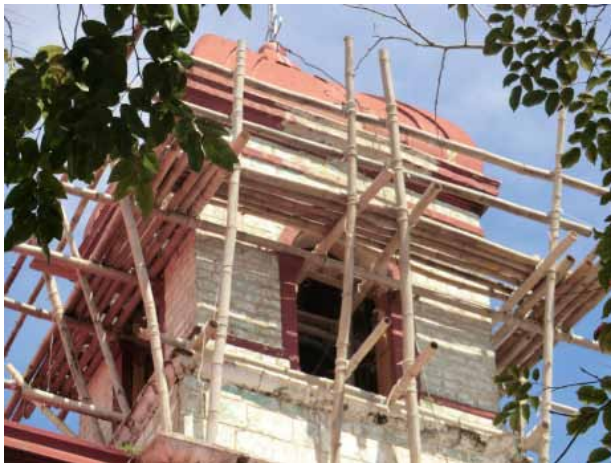
図 96. サンタ・カタリナ・デ・アレハンドリア教会鐘樓の ひび割れの修復（被災後）
