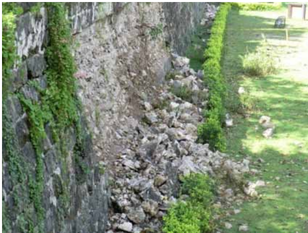
図 84. サン・ペドロ要塞の壊れた石造の壁（被災後）
