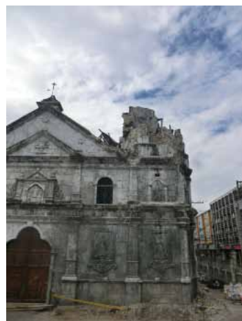
図 87. バシリカ・ミノレ・デル・サント・ニーニョ の崩壊した鐘楼（被災後）
