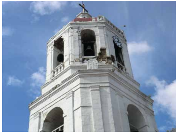
図 89. メトロポリタン大聖堂鐘樓のひび割れ（被災後）
