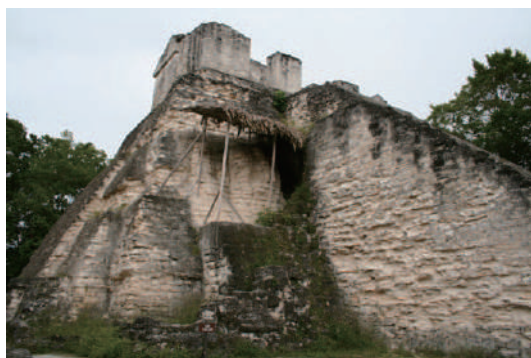
▲ 浸食・溶解が進む「北のアクロポリス」の建造物5D-22
