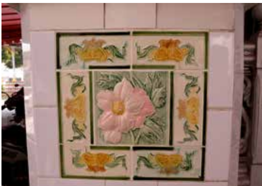
図 5. タイル表面に修理年号が刻印されている
