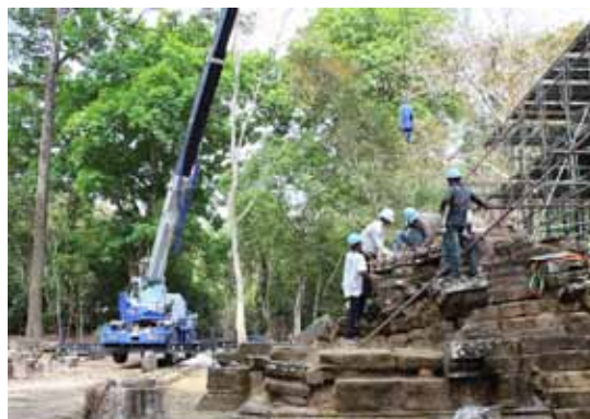
西トップ遺跡の解体修復 1
