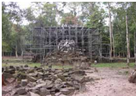
サポート解体前の南祠堂
