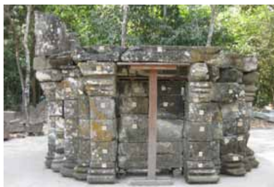
西トップ遺跡の解体修復 2
