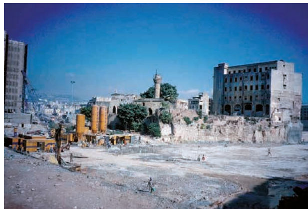
図2 1994年、レバノン、ベイルートの市街中心部
