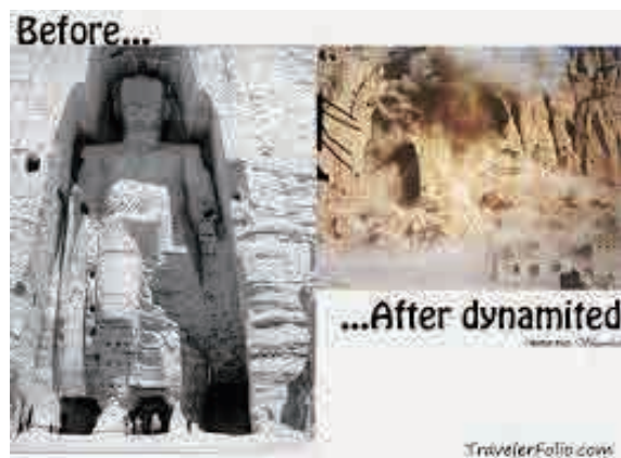
図12 左：破壊前、右：破壊後
