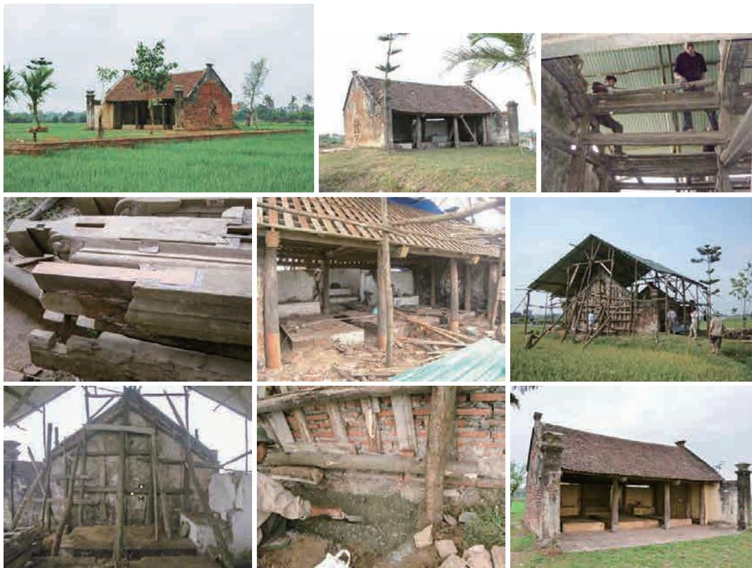
傾斜したラテライト壁の修復はサンドイッチにして立て起こす手法を採用。
