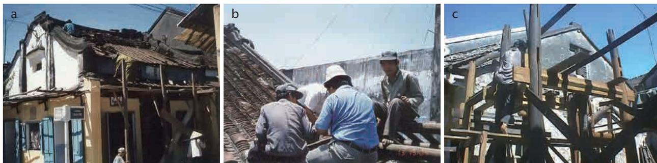
雨漏りを解消する屋根替え工事
