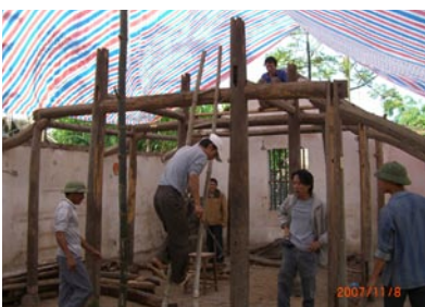
Nu 邸解体工事
