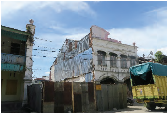
図9 左側が解体された状態（2017年8月撮影）
