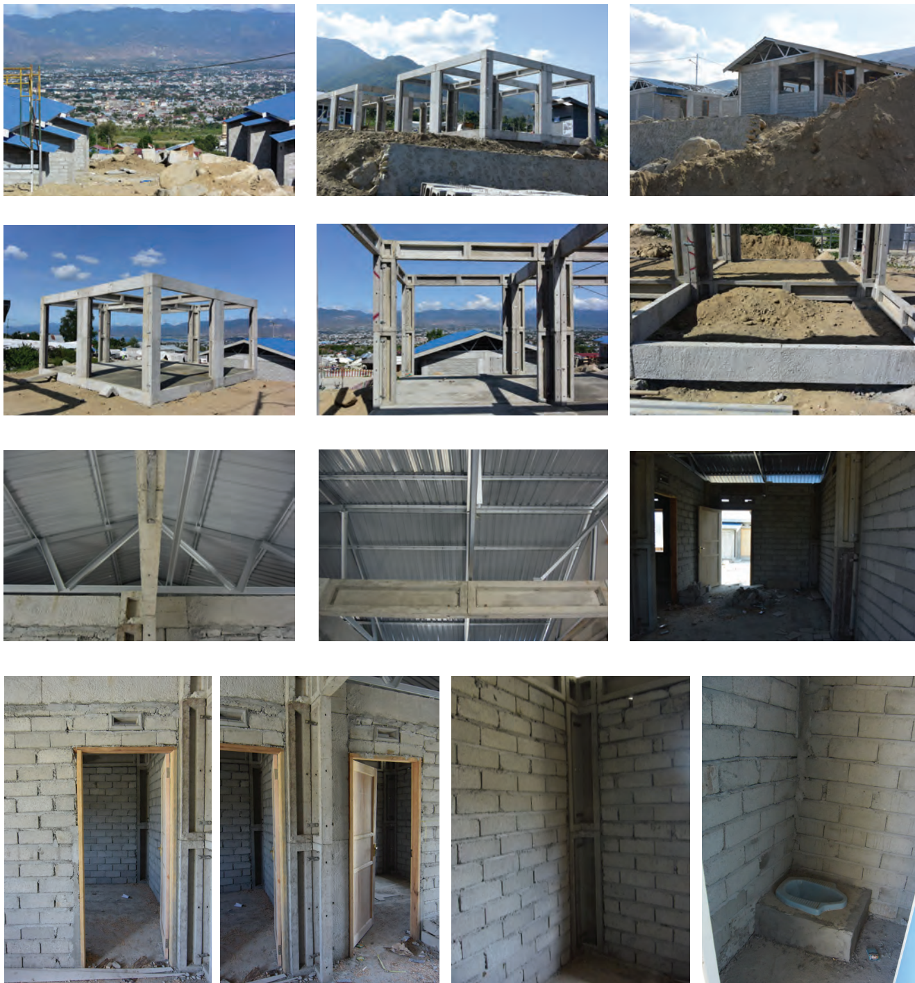
図 20 ドゥユ地区の恒久住宅（バラロア居住者向け）
