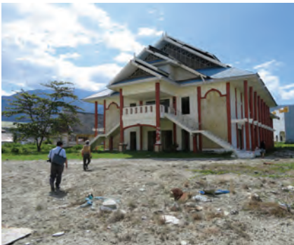
図 3 津波で被災した文化センター
