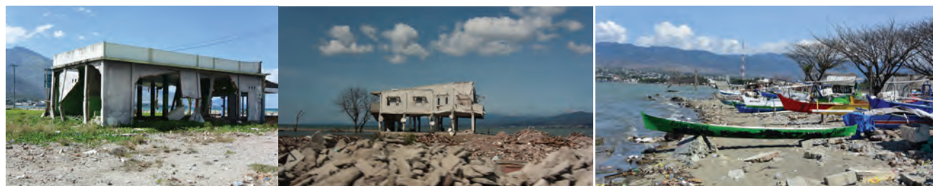
図 6 被災した沿岸部の現況（2020 年 1 月） 援助によって再建された漁船が並ぶ沿岸部。
