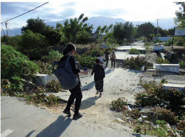
図5 ペトゴ地区 液状化地滑り地域
