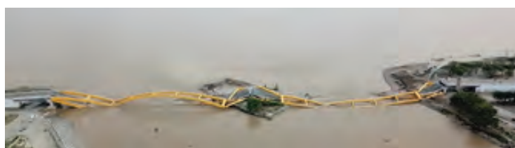
図 4 （上）津波被害地区 （下）落橋した河口橋
