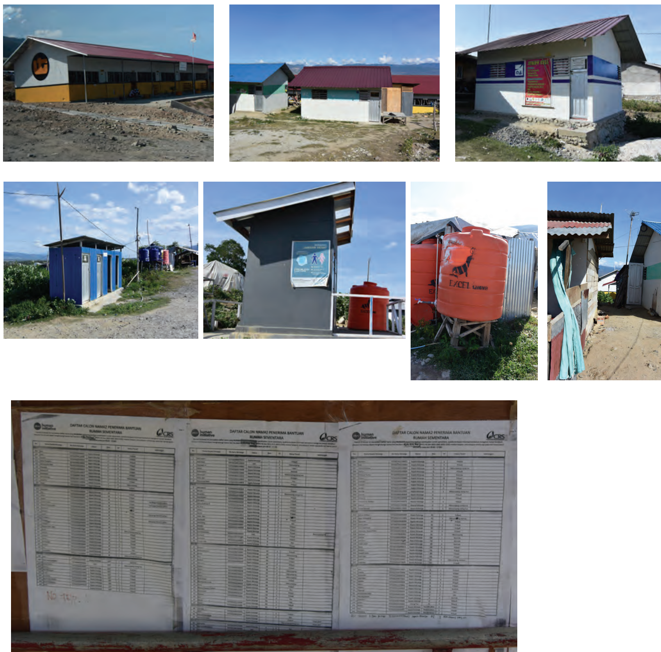
図 19 バラロアの木造住宅と共用施設（トイレ・クリニック・給水タンク）ブロック別居住者名簿
