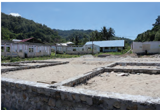
図 7 広場の建設予定地
