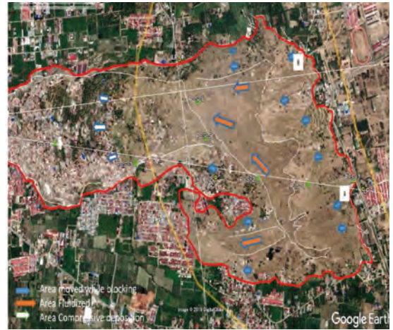
図 12 ペトボ地区の地滑り (JICA 提供)
