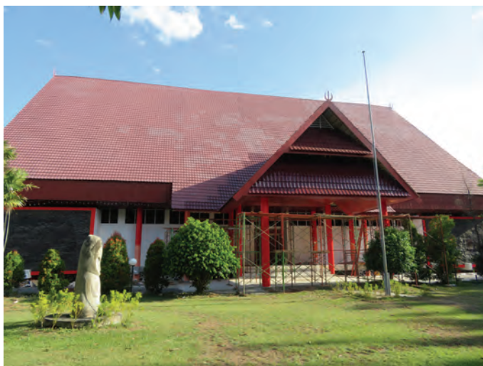
図1 改修中の本館
