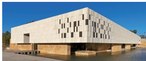
無償資金協力を通じて建設したペトラ博物館
