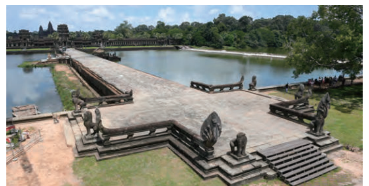
西参道修復工事完了後（2023年11月）
