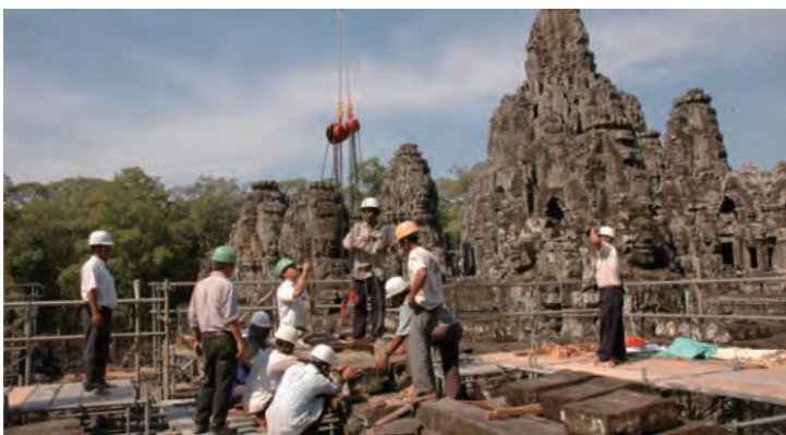
バイヨン寺院南経蔵における修復工事
