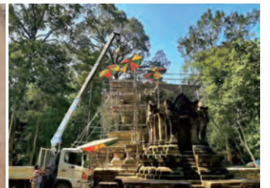
中央祠堂再構築工事の様子（南から）
