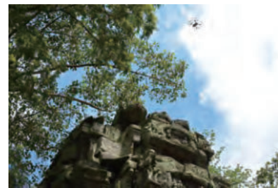
ドローンによる中心伽藍危険箇所調査
