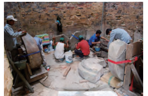
煉瓦造祠堂内の神像が安置されていた石造台座の修復工事 （アンコールで育成されたカンボジア人専門家からの国内での技術移転の現場）
