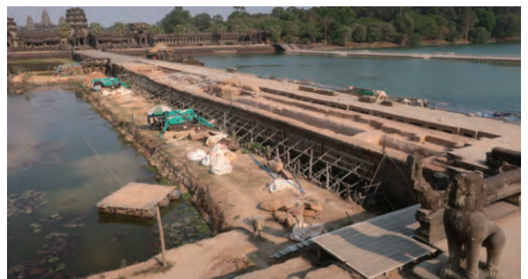
西参道修復工事の様子（2020年3月）
