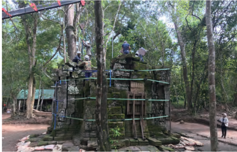
東門解体修復工事の様子
