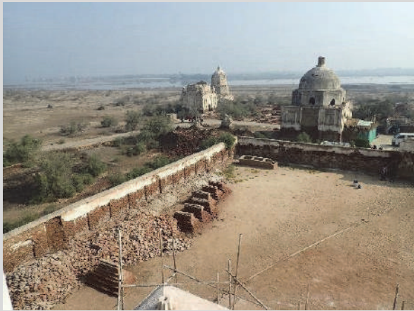
図 90 本来、ミアン・ヌール・ムハンマド・カルホロ廟墓群の東側は畑地であるが、現在でも水没している。
