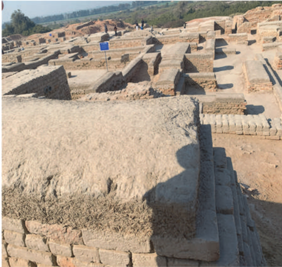
図 61 極端な気候・気象条件から遺跡（壁やストゥーパのドームなど）を保護するために、スラリーや泥でキャッピングされている遺跡の様子。
