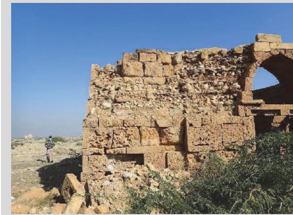
図 120 石積みの建造物の構造。崩落により壁の内部が露出したことで、構造が明らかとなった。
