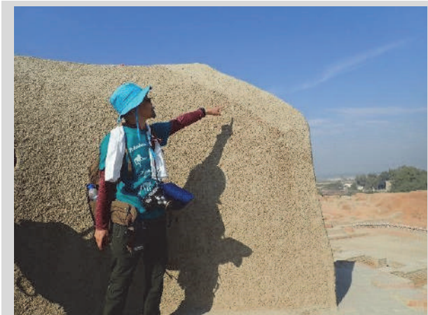
図 64 シタデル地区ストウパ上部の養生。指をさしている部分から前面は崩落した部分を修復した場所。
