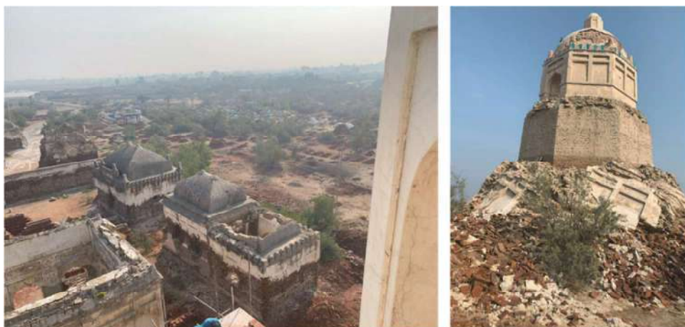
図 86 ドーム型構造物／墳墓の損害状況。
