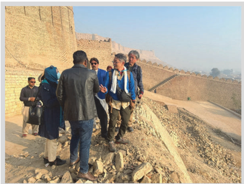
豪雨による水流によって崩れた、コート ディジー城の擁壁の視察。
