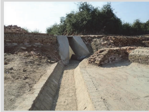
図 62 モヘンジョダロ HR 地区に整備されている排水路。2022 年洪水の時にはゴミ等で塞がれていた。
