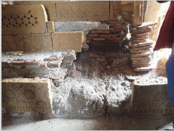
図 105 図 104 左側の廟の中に安置されている墓の下部。塩類風化が著しい。
