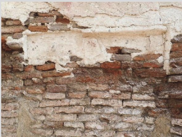
図 92 レンガ積みの壁体に直接漆喰モルタルを塗り付けている部分もある。泥土塗りを持つ部分との新旧は不明。
