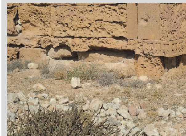
図 121 石積みの建造物の下部において確認される塩類風化。
