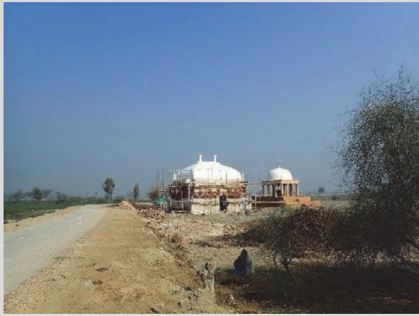
図 104 写真右側の廟は 2022 年洪水でドームが崩落したものを修復したもの。
