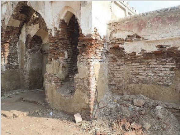
図 91 壁の基本構造。レンガ積みの壁体に泥土を塗り、その上に漆喰を施している。
