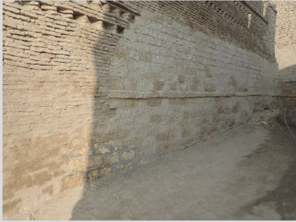
図 80 オリジナルの材料および構造と異なる方法により進められている修復。
