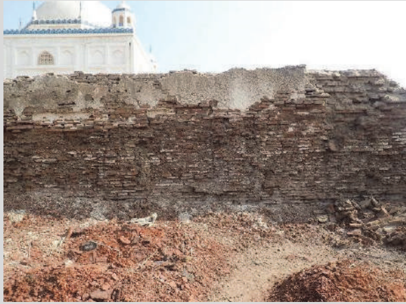
図 94 北壁の北面（図 93 の反対側）では、塩類風化が認められる。
