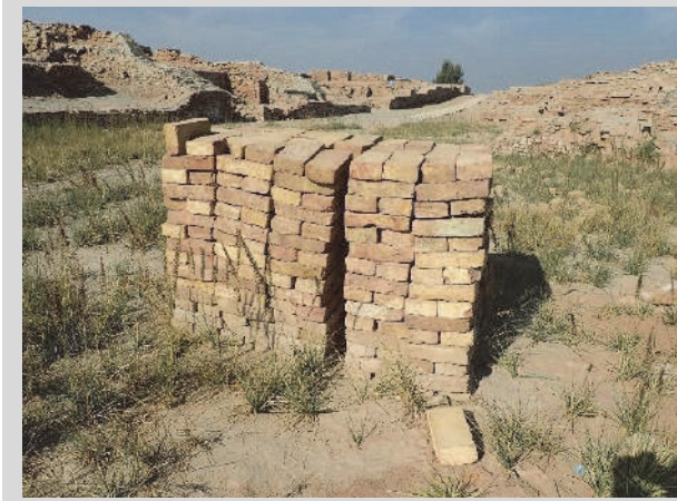
図 67 修復用の焼成レンガ。塩類風化で崩落した部分のレンガを補修用のレンガで置き換える。
