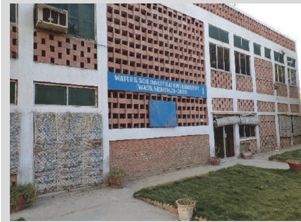
図 66 水と土壌の調査実験室。修復用のレンガを作るための土の分析等を行っている。
