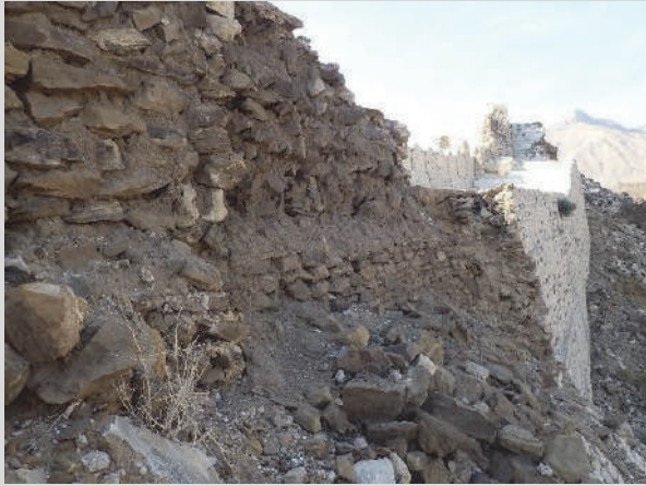
図 110 城壁の構造。砂岩の平石の積層、ブロック状砂岩の積み上げが認められる。
