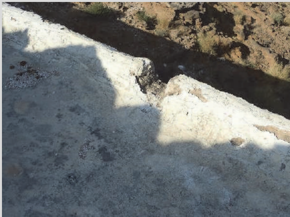
図 111 通路部分に塗られている漆喰モルタル。ところどころに排水のためのスリットが切られている。
