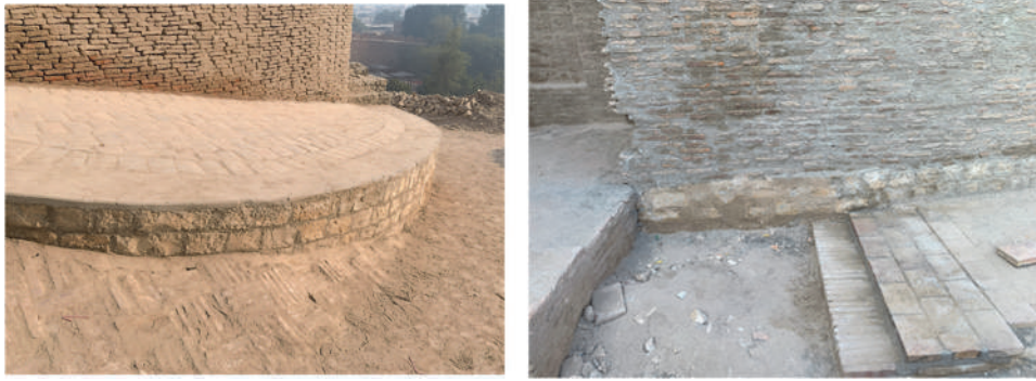
図 74 修復作業中の通路やデッキ、壁。
