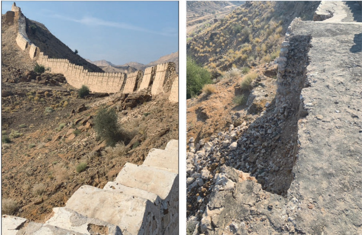
図 107 壁や土台の損害。
