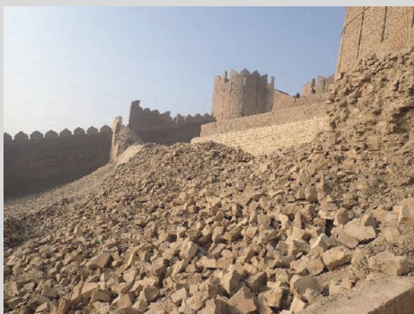
図 79 1955 年におこなわれた修復での城壁の構造。人頭大の石灰岩礫と泥土を壁体とし、表面に石灰岩ブロックを積む。
