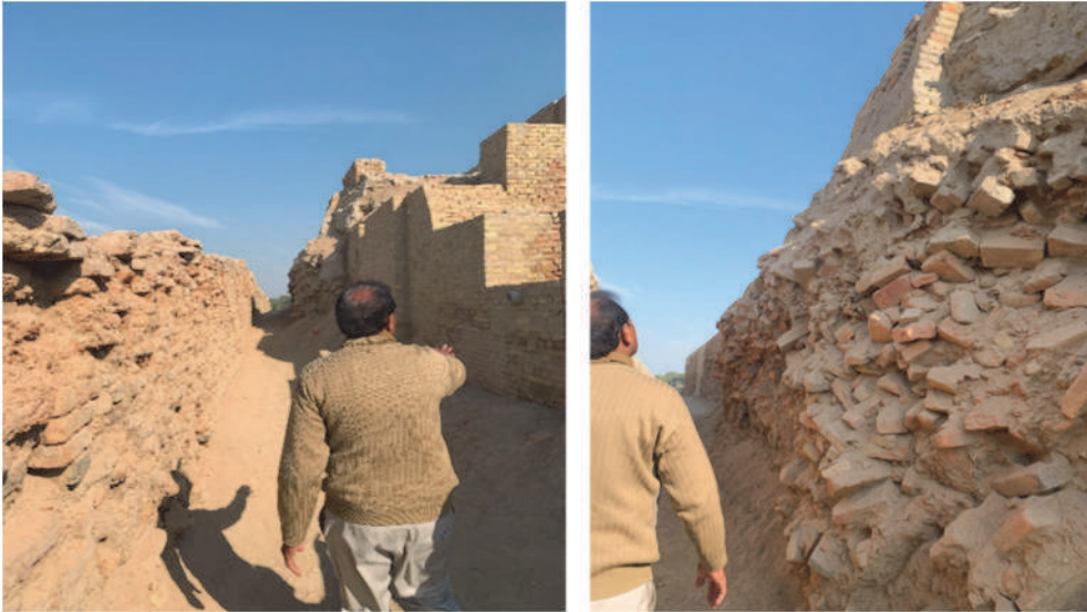
図 59 左：遺跡の現状。壁は保存修復され、下地には泥と藁が使用されている。 右：崩壊した壁の様子。適切な保存修復が必要とされている。
