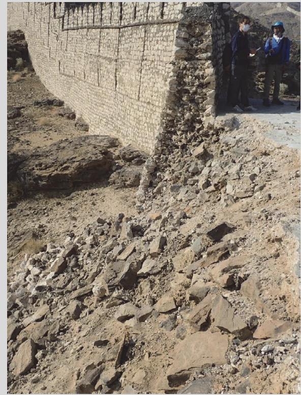
図 114 石灰岩等の礫と泥土で壁体を構築し、化粧に石灰岩を用いている部分。
