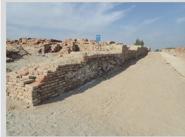
図 65 塩類風化が進行しているレンガ壁。塩類風化は遺跡全体で見られ、対策の検討が必要である。
