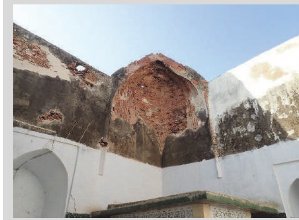
図 117 レンガ積みを主とする建物のドーム部分のレンガ積み。
