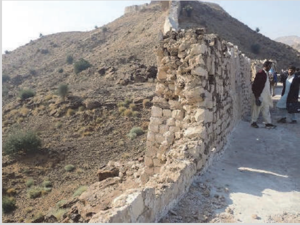
図 113 石灰岩のみを積み上げて壁体を構築している部分。
